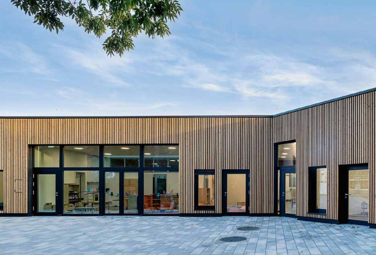
▲ Dank hohem Vorfertigungsgrad dauerte es gerade einmal vier Monate, bis die in Holzständerbauweise errichtete Kindertagesstätte fertiggestellt war
