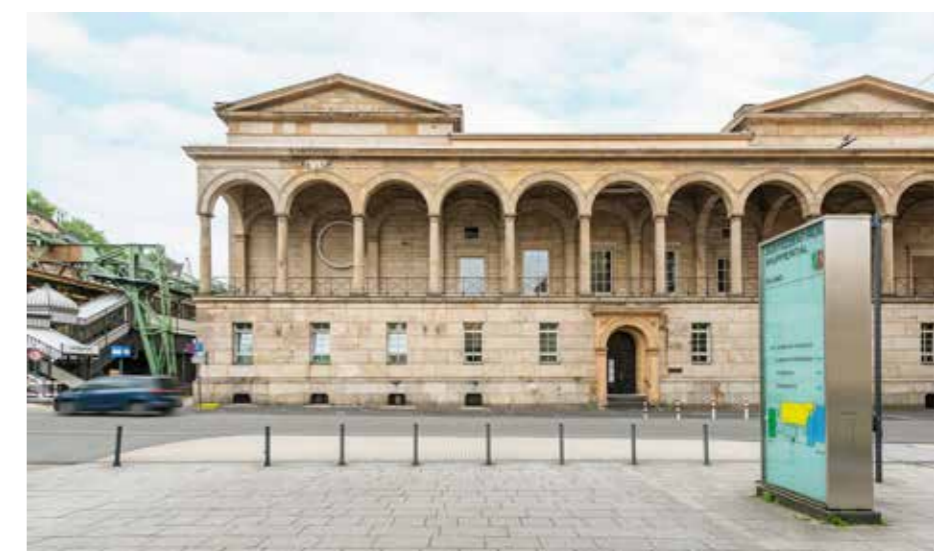
Heizkörper verschwinden in kleinen Nischen in der Wandverkleidung (oben)
