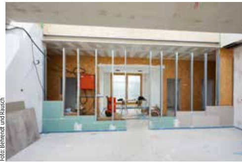
Unterkonstruktion aus CW- und UW-Profilen für die anschließende Beplankung mit Gipskarton
