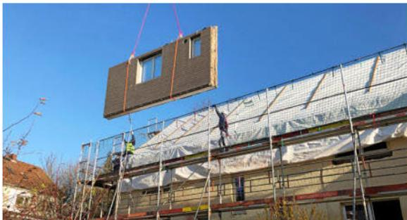
Baustelle der Firma Brinkmann in Hameln: Hier montieren Mitarbeiter ein Fassadenteil in Modulbauweise.
