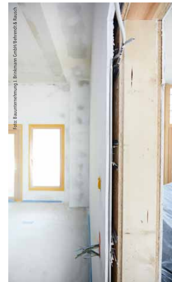
Ruhezone. Um für Schallschutz zu sorgen, wurden die Holzständerwände auf Hut-Federschienen mit einer doppelten Lage Bauplatten RB beplankt.
