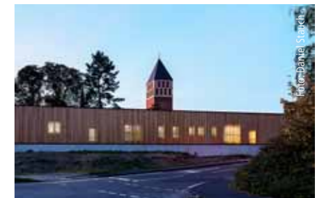
Gestalteter Lärmschutz. Die Außenwände der Kita, die direkt an eine Bundesstraße grenzen, wurden mit einer Lamellenfassade aus Lärchenholz als Lärmschutzwand konzipiert.
