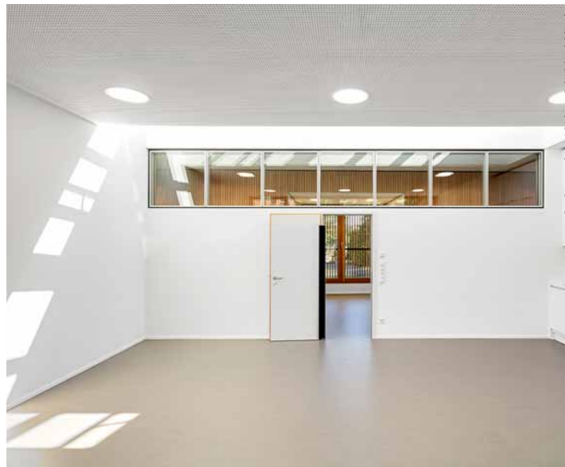
Licht und eben. Glasoberlichter bringen Tageslicht in Räume und Flure. Eine Spachtelung der Wände in Q3-Qualität sorgt für eine makellose Wirkung des Lichts auf den Wand- und Deckenflächen.
