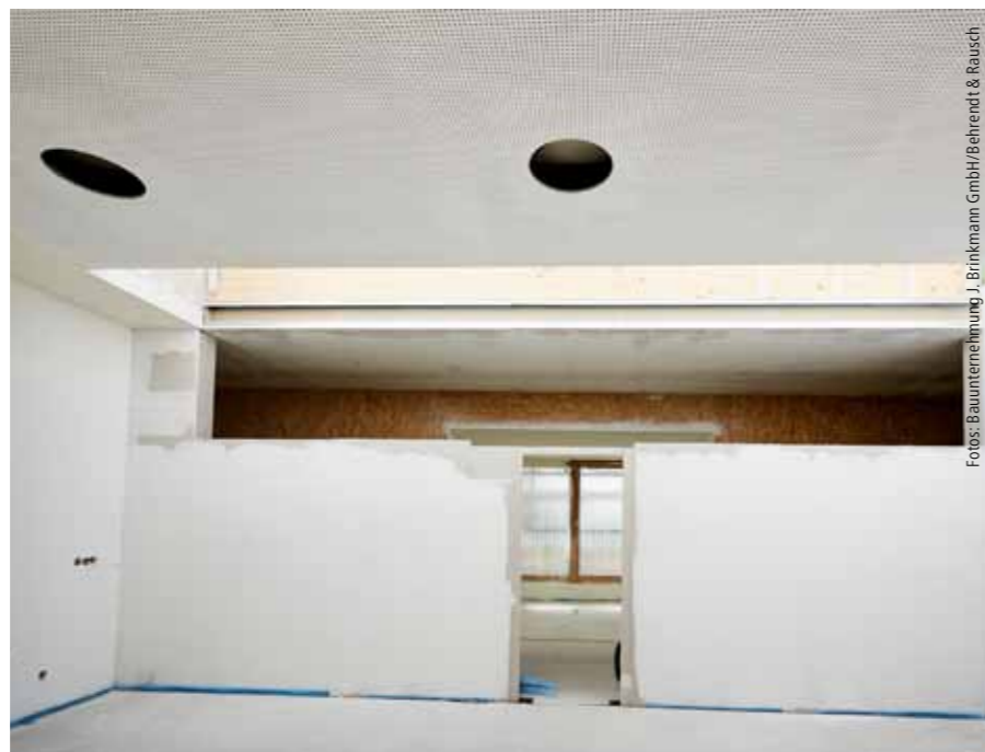
Stabil. Die Statik der freistehenden Wände oblag dem Ausbaubetrieb. Die Konstruktion aus Stahlstützen, einem durchlaufenden Stahlträger sowie Teleskopanschlüssen an der Wand erzielt eine Tragfähigkeit von 50 kg.
