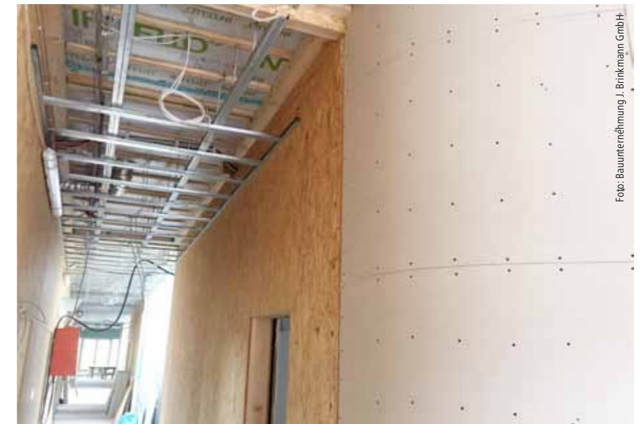
Trapezförmig. Die Flurbreite beträgt im Eingangsbereich 1,80 m und weitet sich im weiteren Verlauf bis auf 2,50 m. Die Unterdecke wurde mit Noniusabhängern direkt an der Holzkonstruktion befestigt.
