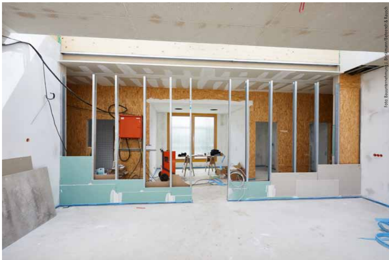
Sonderkonstruktion. Für die Abtrennung der Gruppenräume vom Flur schuf das Trockenbauteam freistehende, halbhohle Wände mit einer Spannweite bis zu 7 m.
