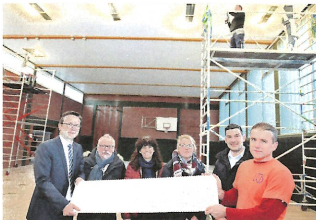
Verschafften sich selbst einen Eindruck von den Sanierungsarbeiten in der Sporthalle der Mariengrundschule: Bürgermeister Sven Kaiser, Andreas Albers vom Sportverein Arminia Kapellen-Hamb, Schulleiterin Angela Huskes, Kapellens Ortsbürgermeisterin Andrea Dahmen sowie Bauleiter Hendrik Hergens und Mladenco Latic vom Oberhausener Akustikdecken-Experten und Trockenbauer Brinkmann (von links). Foto: Stadt Geldern
