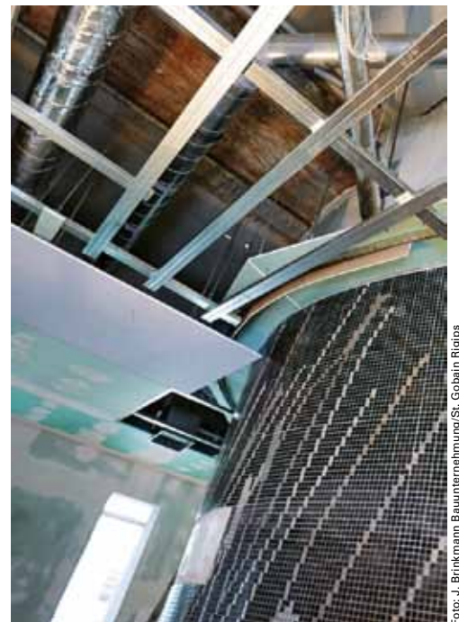
Foto: J. Brinkmann Bauunternehmung/St. Gobain Rigips
