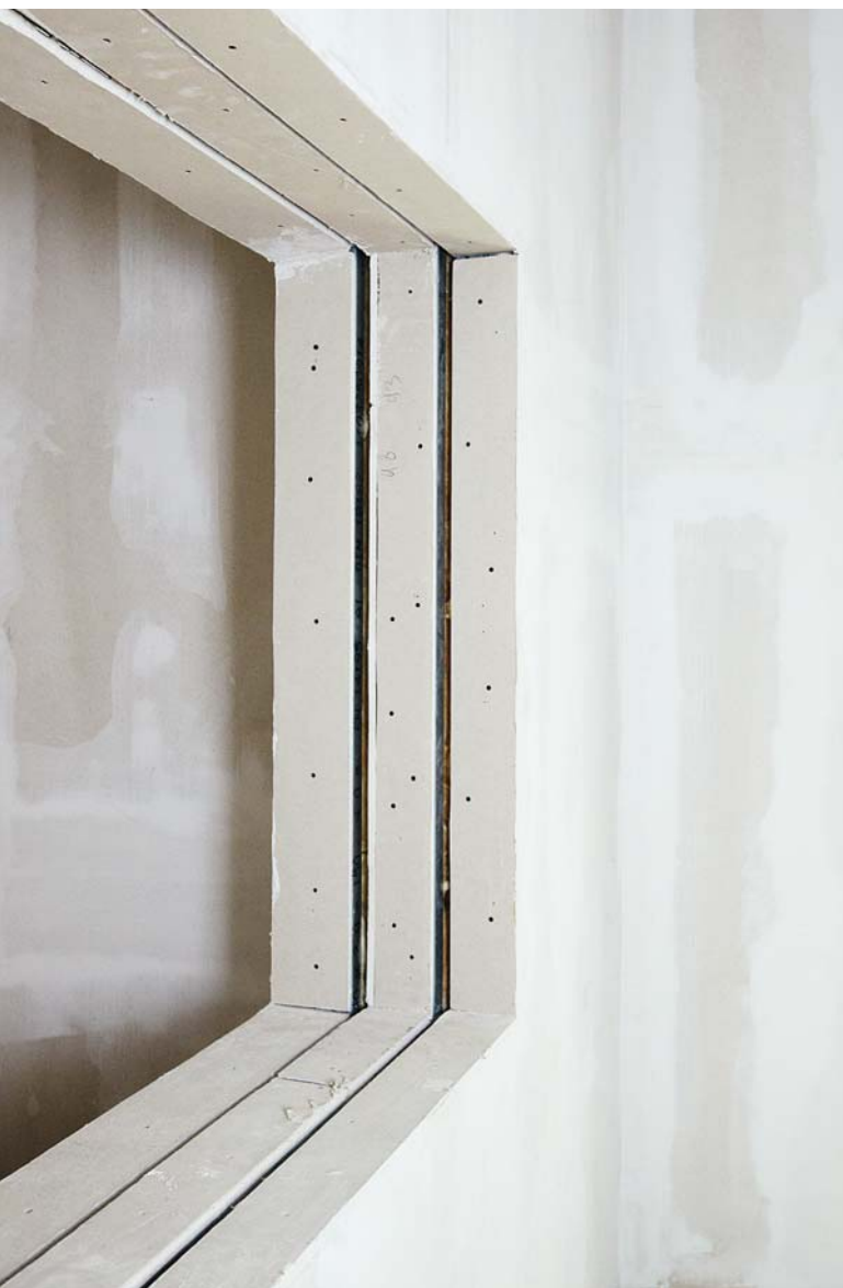
Massiver Schallschutz. Eine mittig platzierte Schallschutzwand und zwei Vorsatzschalen mit insgesamt zwölf Lagen der Schallschutzplatte „Die Blaue“ trennen Aufnahme- und Regieräume voneinander.
